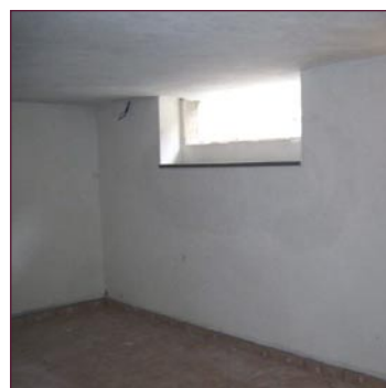
■ A fianco, i supporti gravemente ammalorati prima dell'intervento e perfettamente ripristinati con Coprox®.
